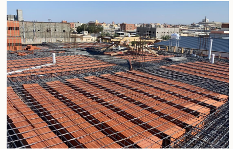
الهيكل الخرساني مجمع سكني - أبرق الرغامة
